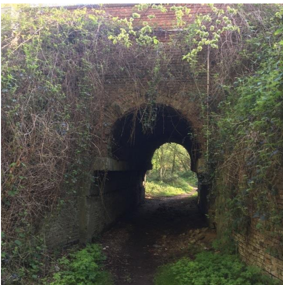
Tunnel onder Kapelstraat
