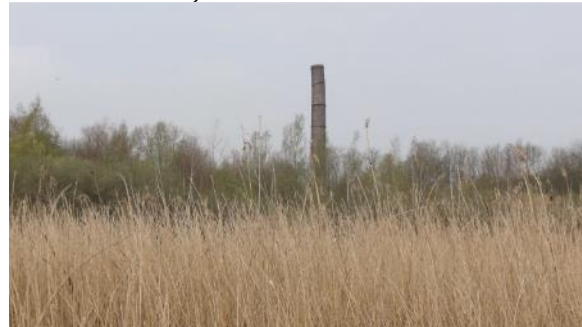
Schoorsteen machineconstructieplaats Landuyt (R06)
