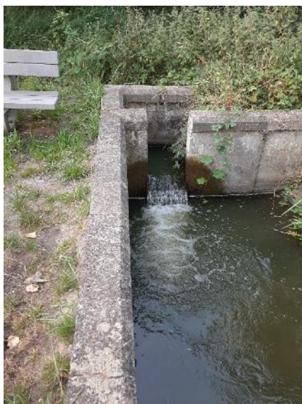
Figuur 80: Colateur komt onder de snelweg door, ter hoogte van de straat Watering.
