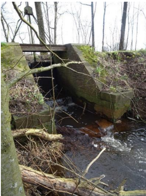
Figuur 51: Afsluiter van de Colateur naar het Goorneetje vanuit het Goorneetje gezien (24-02-2022).
