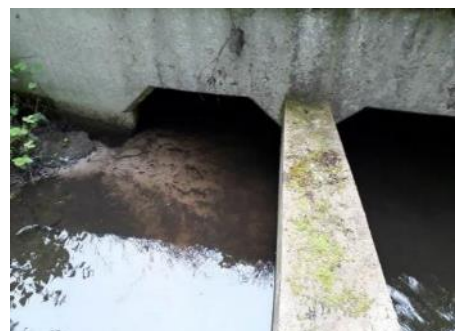
Figuur 82: Onderdoorgang snelweg.
